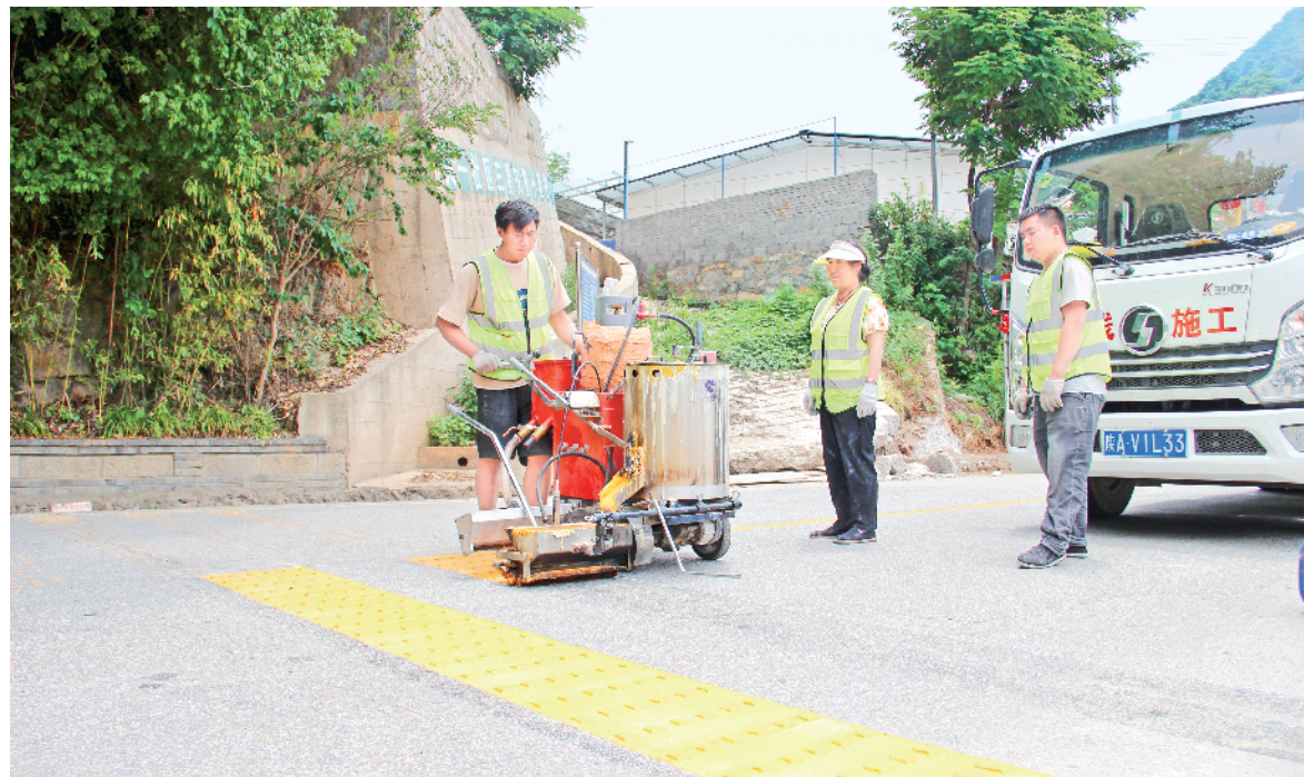
日前,宁陕县G210公路上施工工人正在进行沿线道路标线施划。施工完成后,将彻底改变原有标识标线不连续、不清晰现象,进一步提升城市道路形象,保障道路交通安全、畅通、有序。
