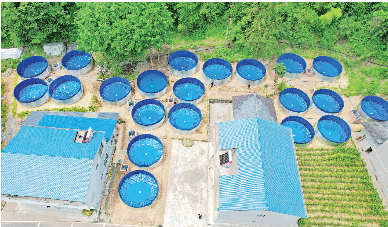
为加快集体经济发展,促进特色产业和镇域重点项目落地生根,岚皋县石门镇大河村加紧建设陆基养鱼项目。因为日前航拍的已全部完工的陆基鱼池。 柯明宇 摄
