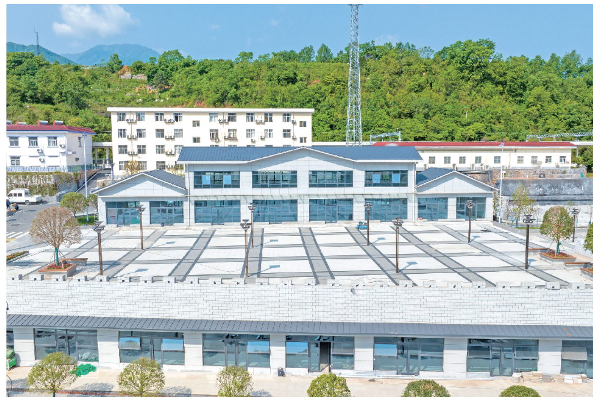
在刚刚过去的“五一”假期,提档升级后的汉阴火车站前广场正式投入使用。经过两年来的提升改建,新汉阴火车站前广场占地面积21000平方米,公共停车场、商业建筑、景观绿地等区域规划合理,在主广场与出站口之间,设置了车辆临时通道和多个公共停车位,并施划了清晰的标志标线,以指引车辆进出方向。接送车辆可在这条通道上快速通过,最大限度方便旅客。王磊 摄
