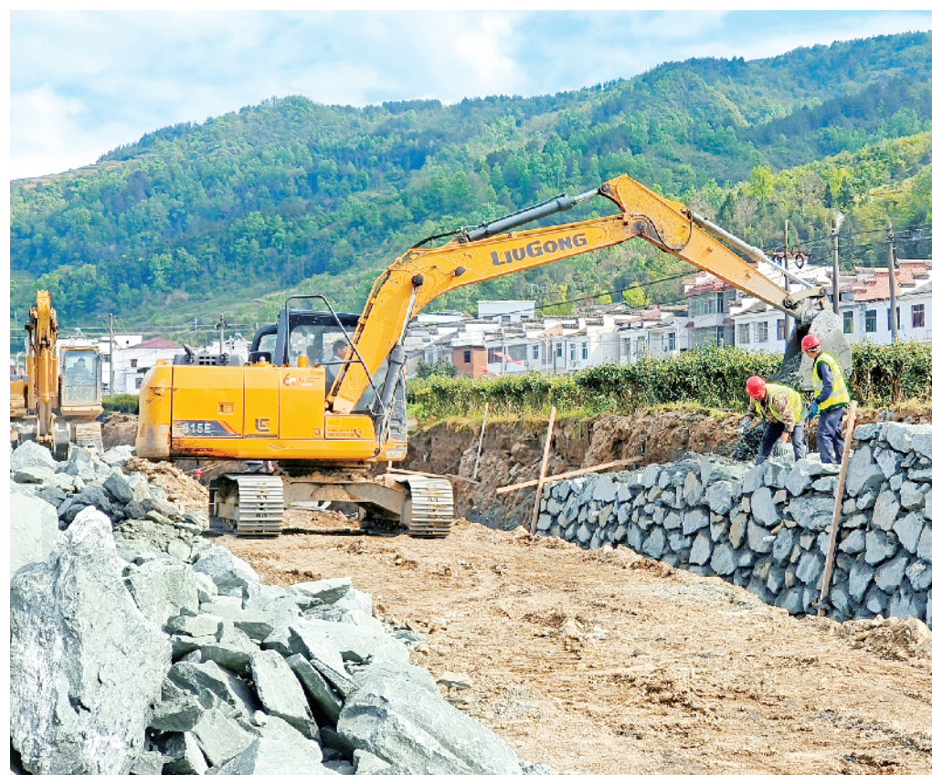
平利县水系连通及水美乡村建设项目自2023年6月30日开工建设以来,按照批准实施方案中的“1561”建设路径和批复的初步设计建设内容,精心安排、科学组织、稳步推进实施,图为长安河水系地段项目施工现场。
