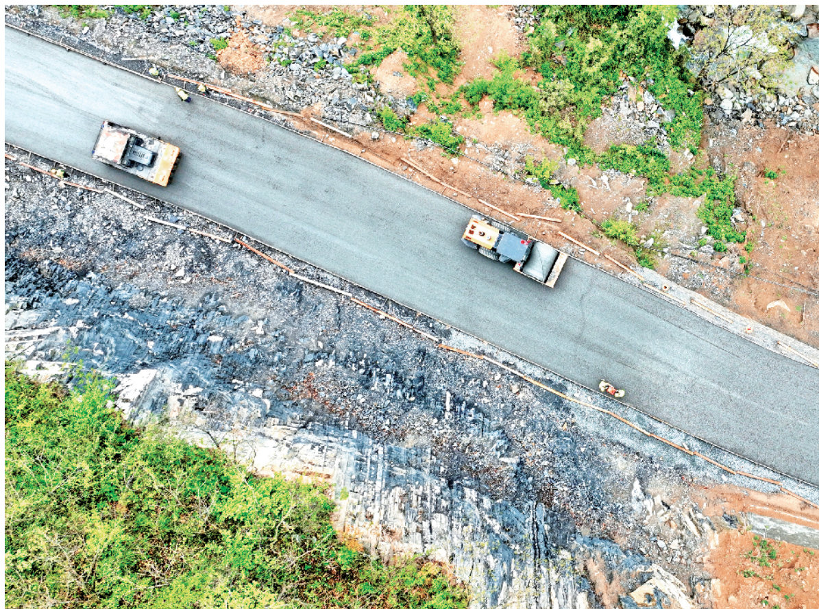
连日来，在平利县正阳镇渡正路改建工程项目建设现场，工人们抓工期、赶进度，全力以赴推进项目建设。图为工人们正在进行水稳摊铺。
