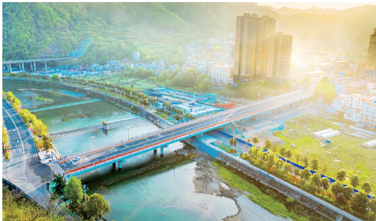
4月8日上午8时,平利西大桥拆建重建项目圆满完成,正式通车。该项目于2023年3月17日开工建设,起点为西关路交叉路口与新正街相接处,终点与346国道和迎宾大道连接,全长433.5米,宽25米,采用城市主干道标准建设,双向四车道,两边专门设计了人行道和非机动车道。
