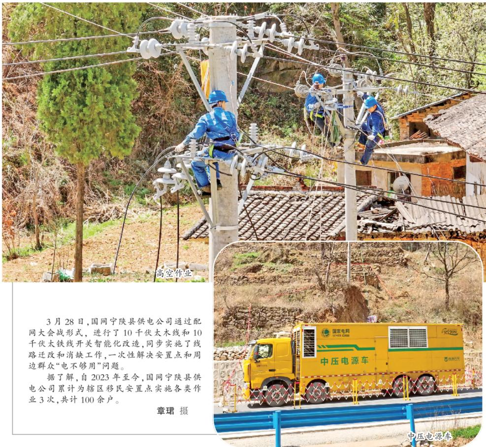
3月28日，国网陕县供电公司通过配网大会战形式，进行了10千伏太木线和10千伏太铁线开关智能化改造，同步实施了线路迁改和消缺工作，一次性解决安置点和周边群众“电不够用”问题。
