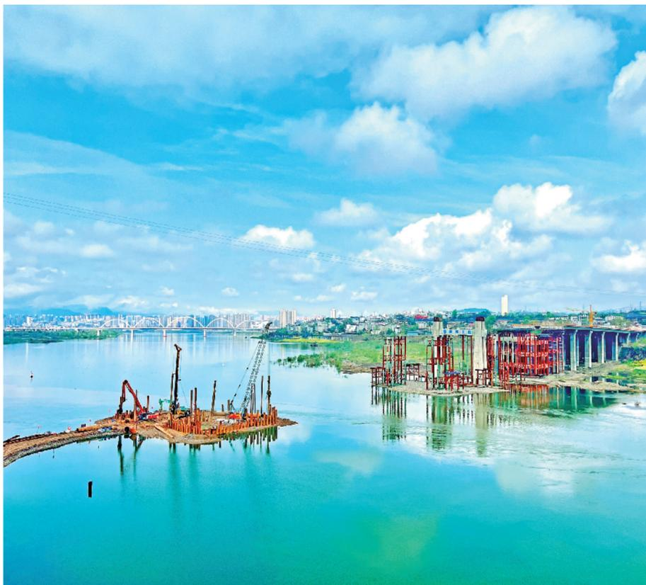
近日,在安康新关庙汉江大桥施工现场,大型机械在水中主塔、水下承台钢围堰防护桩施工。工程人员抢抓春季低水位施工黄金期,紧张有序地进行作业。钱远立 王伟 摄
