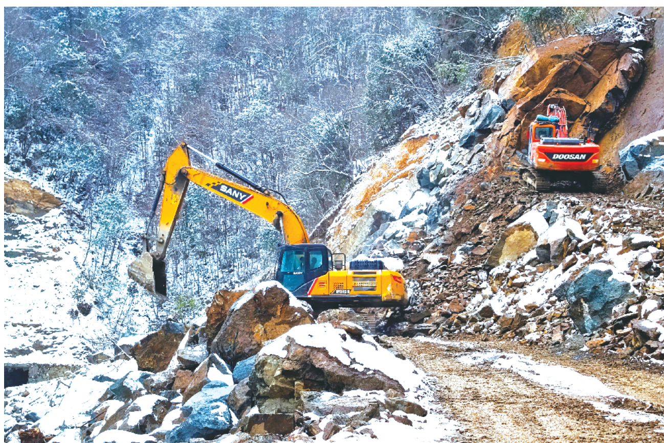
平利县渡正公路起点在正阳镇渡船口,终点在陕渝界接重庆市城口县501省道,全长45.503公里。此次改建按三级公路标准设计,路基宽度7.5米,路面宽度6.9米,全线采用沥青混凝土路面。项目建成后,将打破该县南部地区的交通瓶颈。3月初,施工人员在平利县渡正公路加紧施工。
