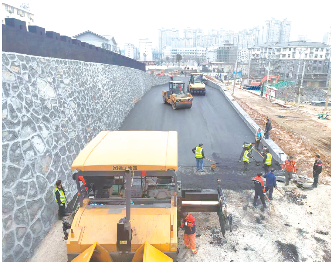
时下正是大抓项目建设的重要时期,3月6日,汉阴县火车站前广场项目进入竣工冲刺阶段,工人们赶进度、抢工期,力争惠民项目早日完工。张辉 摄
