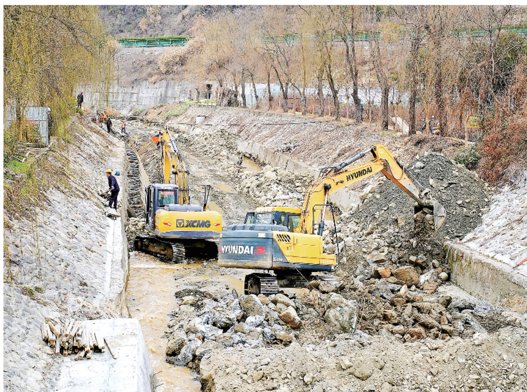
人勤春来早，复工复产忙。连日来，在平利县各水系连通及水美乡村项目建设现场，机械轰鸣、人头攒动，项目施工正在如火如荼进行，管理和施工双方严把安全关和质量关，高质量推进项目建设，确保项目早建成、群众早受益。王籍 摄
