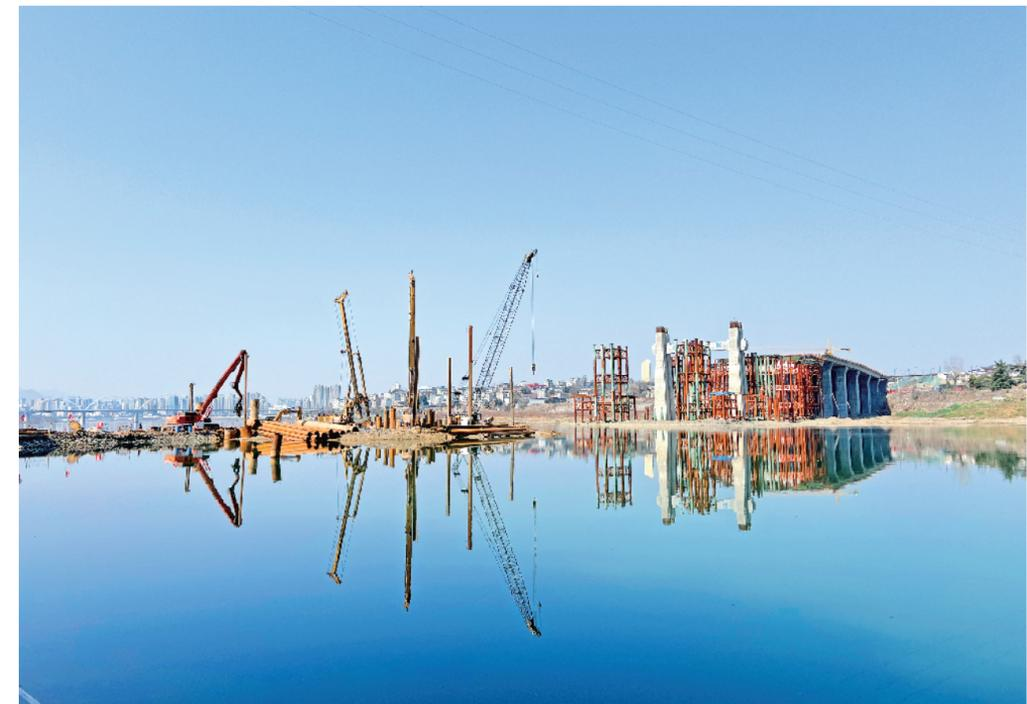
大型机械在安康新关庙汉江大桥施工现场,进行水中主塔施工,建筑工人抢抓冬春枯水施工黄金期,冲刺工程进度。据了解,目前桩基全部完成,墩台完成33个,北引桥箱梁主体贯通。钱运立 郑才林 摄
