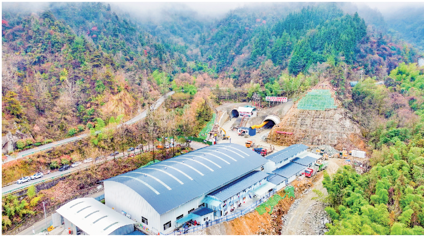
在汉阴县S213凤凰山隧道及引线工程施工现场,工人们正在抢抓时间,全力推进工程建设。该工程目前已完成钢筋加工棚、混凝土拌合站等临建设施,分两个作业面分别从隧道进出口施工,计划在2025年12月实现隧道主体贯通,2026年7月建成通车。项目建成后,汉渝公路的里程将从原来的51公里缩短至29公里,通行时间也将从原来的80分钟缩短至45分钟。
