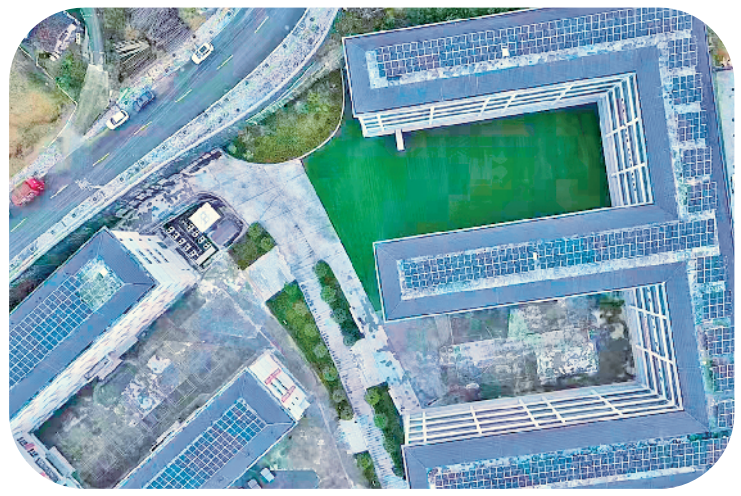
屋顶分布式光伏建设项目
