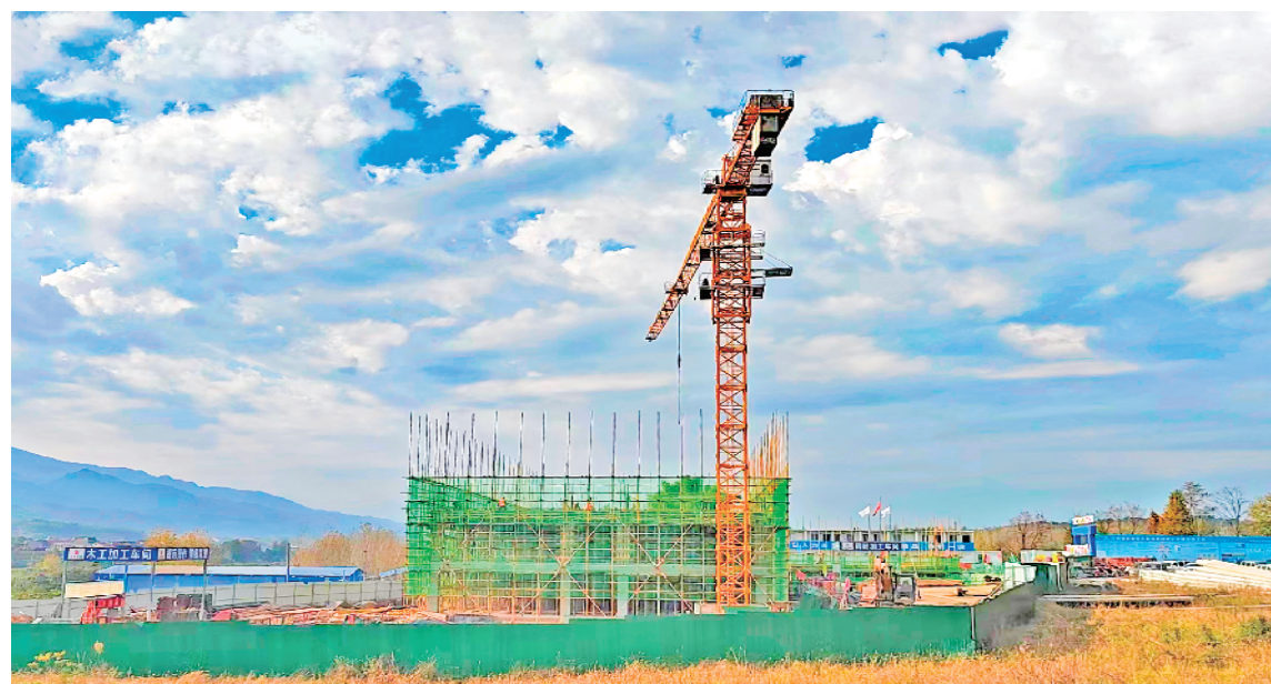
汉阴县职教中心迁建施工现场近日机器轰鸣,工人们正在紧锣密鼓地进行施工。张辉 摄
