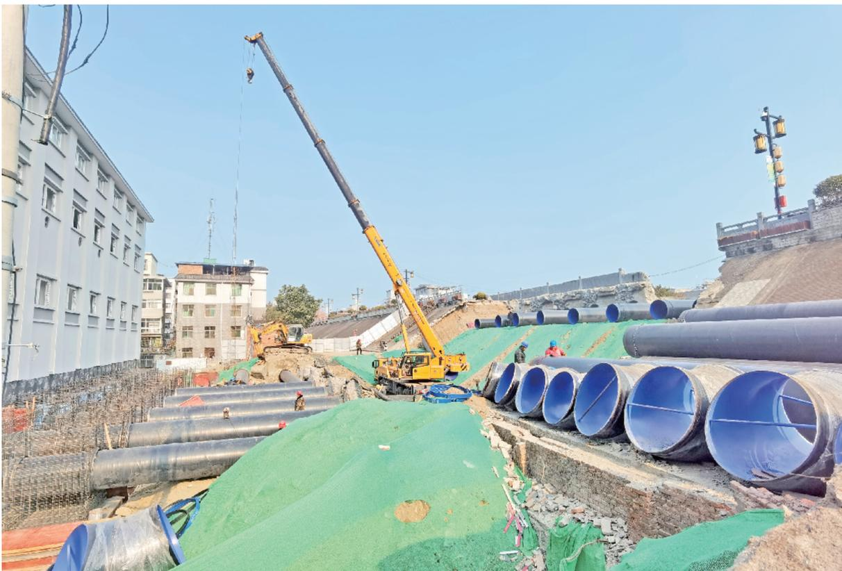
2023年12月27日,安康城区喇叭洞泵站扩容改造项目正在施工。该项目是市委、市政府确定的重点城建项目,此次喇叭洞泵站扩容改造工程量除了新建一栋水泵房外,还将原1000立方米的蓄水池扩大为12000立方米,安装0台大功率混流泵,建成后的泵站抽排能力将提升10倍。吴定国摄
