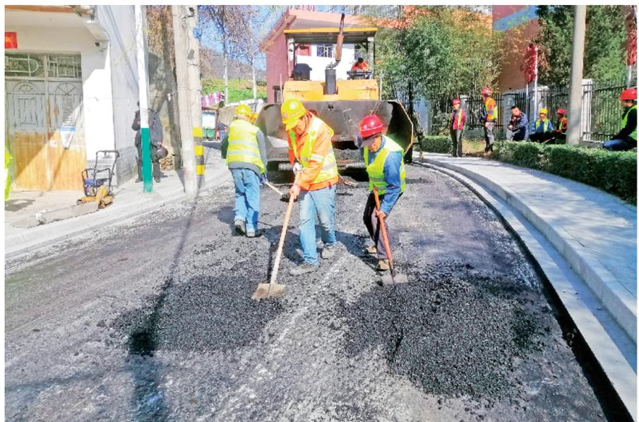
岚皋县佐龙镇投资 346 万元实施集镇污水处理厂暨管网提升改造建设项目，这是 12 月 20 日工人正在铺设配套的 1.2 公里沥青路。
