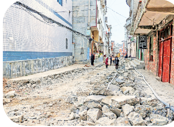
市政基础设施补短板项目施工现场。
