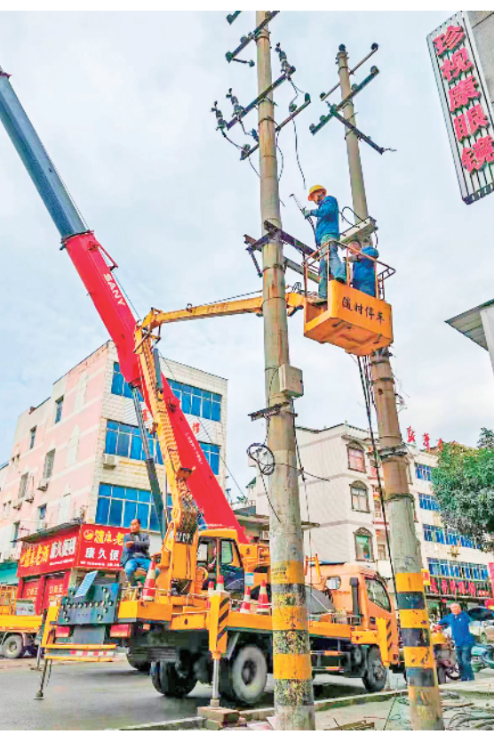
中心大街线路改造施工现场。
