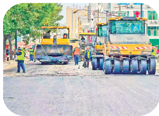
中心大街路面铺设施工现场。
