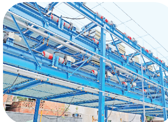
中心大街沿线新建的立体停车场。
