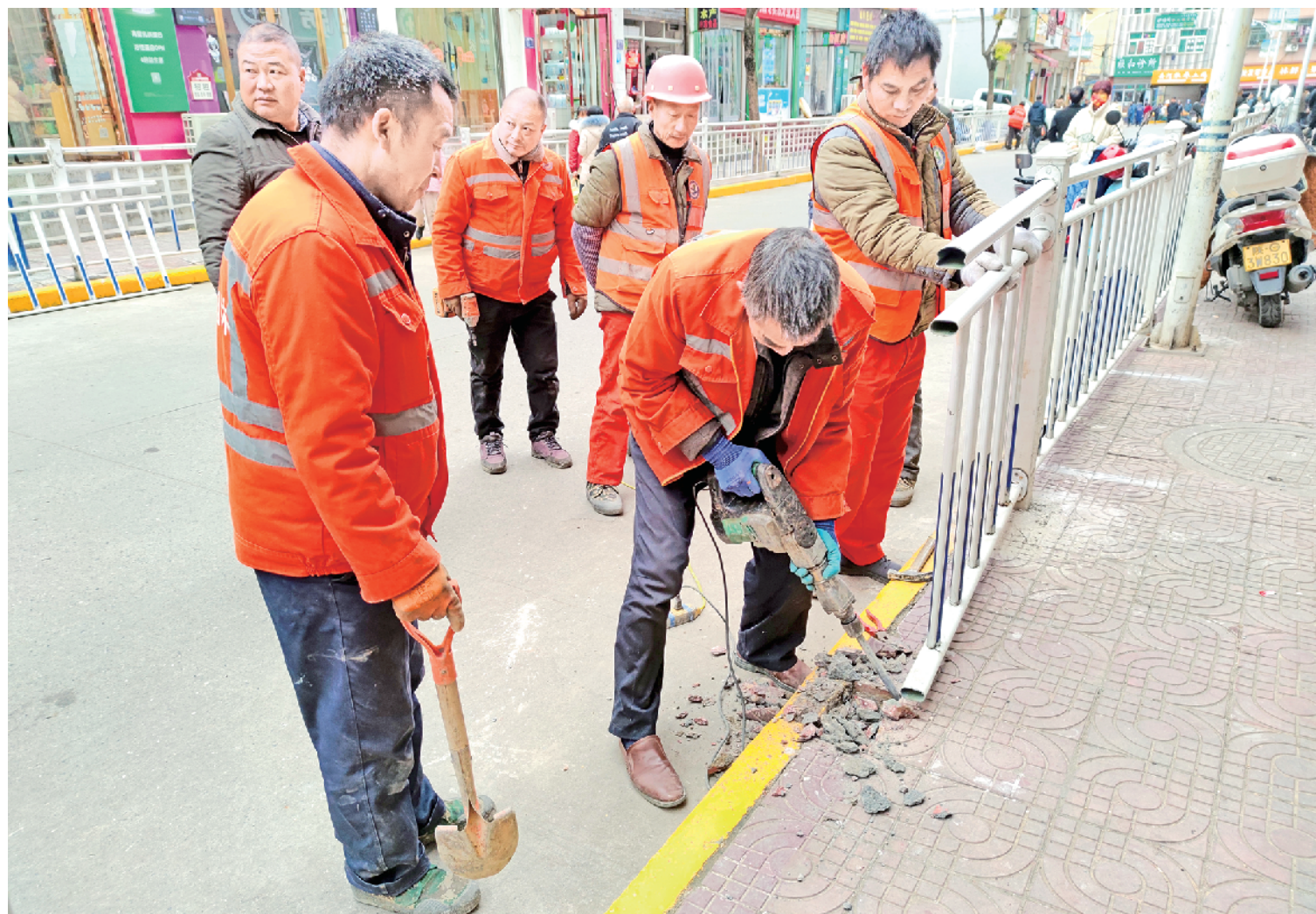
为推动文明城市创建工作,规范农贸市场经营,近日,汉滨区江北街街道在市旅广电部门的配合下,为晏台村农贸市场安装护栏,整治农贸市场占道经营,确保道路畅通、街道干净、行人文明通行。
