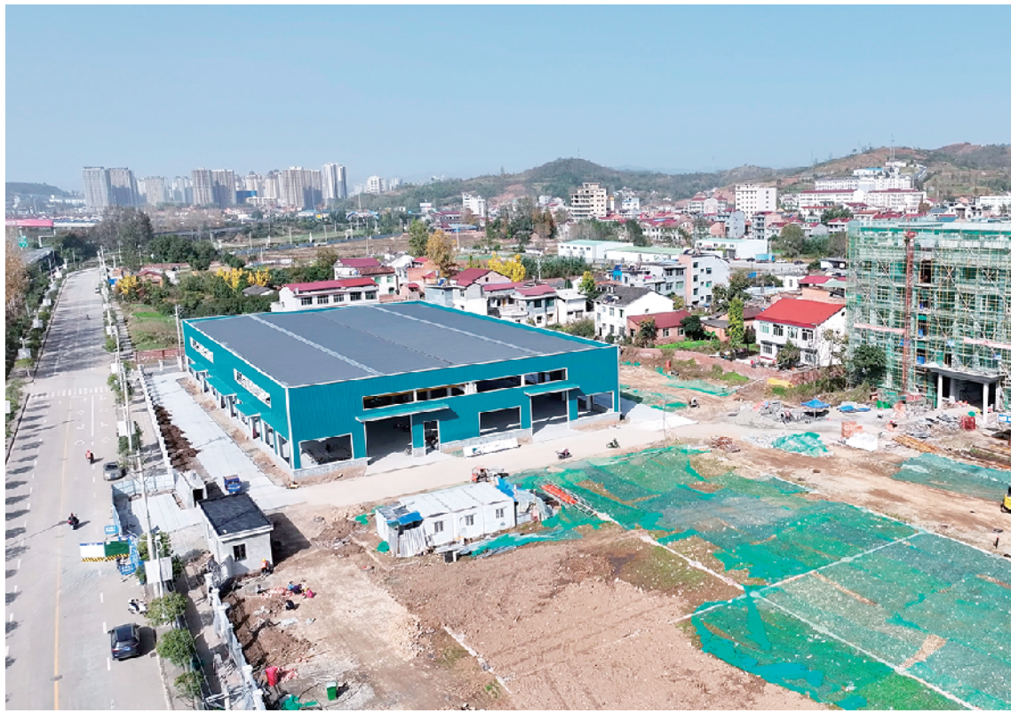
在汉阴县金坤实业有限公司3500平方米的碳素科技研发中心项目建设现场,经过几个月的紧张建设,目前一号楼和二号仓库主体施工已基本完成,正在进行内部装修和外立面装饰工作。工人们各司其职,目之所及,处处是项目建设的火热场面。
