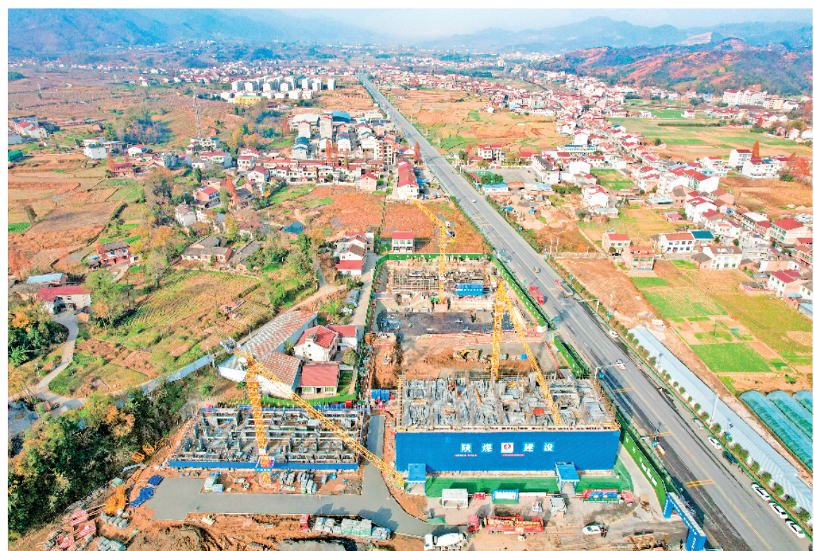
近日，汉阴县实验中学二期工程项目建设现场机器轰鸣，工程人员正在抓紧施工。据介绍，该项目建成后 will 提供学位5000个，实现教学区、生活区、运动区动静分离，为师生提供更加优美的校园环境。张辉 徐欢 摄
