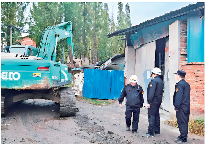
拆除违章建筑，还群众发展空间。
