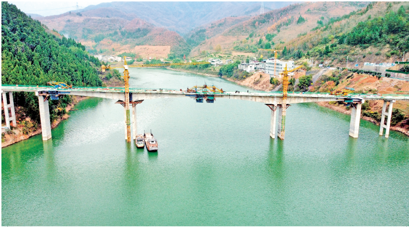
11月30日,随着最后一方混凝土顺利入模,紫阳县又一交通重点项目汉王镇跨汉江大桥顺利完成主桥合龙。该大桥全长356米、宽12米。建成后与国道541和汉江两岸的交通干线有机连接,将结束汉王镇以西沿线群众摆渡过江的历史,极大方便紫阳汉王、焕古、东木和汉阴岚皋两县四镇5万余群众出行。 储茂银 张结 摄
