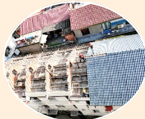
工人正在对安康日报社家属楼房顶进行处理
