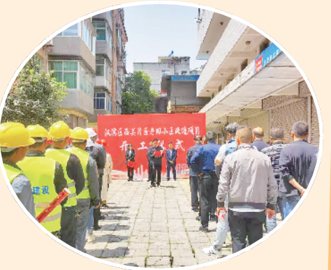
2023年5月，汉滨区西关片区老旧小区改造项目开工
