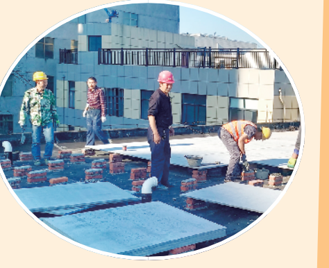
工人正在江北小区铺设隔热层
