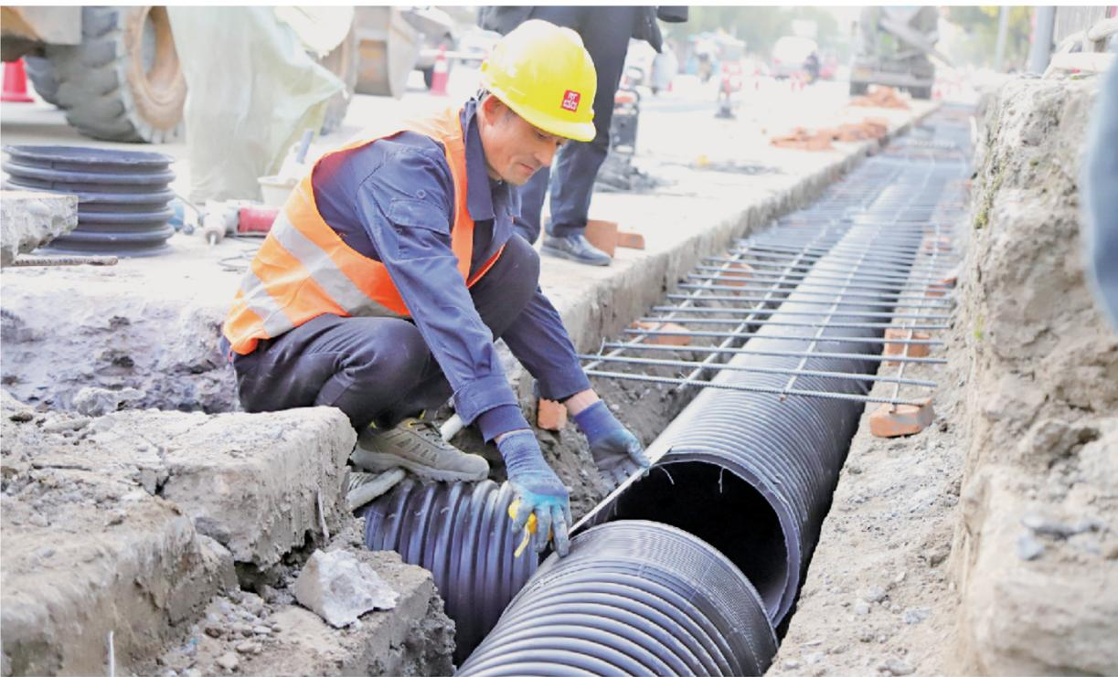
二月廿二日，市市政园林处启动东园路排水管道工程，计划清理沟槽、埋设排水管道、增设雨水井，该工程将解决林处园路沿线边沟破损、黄土裸露、污水淤积等问题。钱运立 摄
