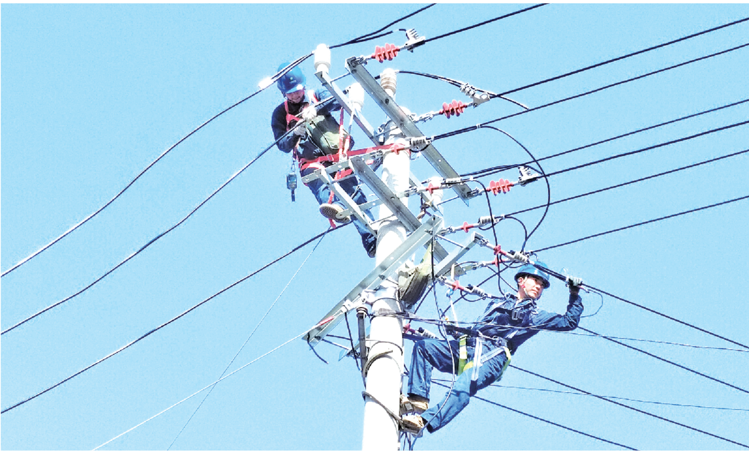
当前正值冬季保供关键时期,国网平利供电公司工作人员积极开展隐患排查工作,全力确保全县群众冬季生产生活用电无忧。图为二月二日,国网平利供电公司工作人员在平利县西河镇东坝村做线路检修。 曾凤鸣 胡珈瑜 摄
