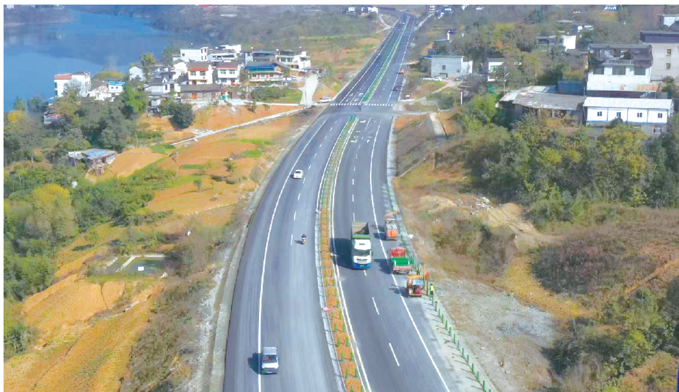
11月19日,汉滨区张石大道路面全线完工。据了解,211国道石梯镇至张滩镇段公路,起点位于石梯汉江大桥头,终点接207省道,全长7.6千米,设计时速60公里每小时。汪海玉 摄
