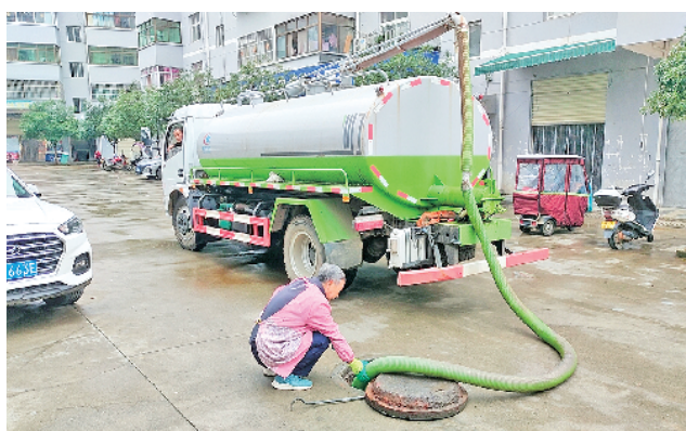
斑桃社区保洁员用吸粪车清理化粪池 陈楚庚 摄
