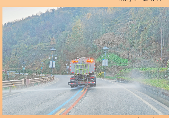
路面冲洗作业
