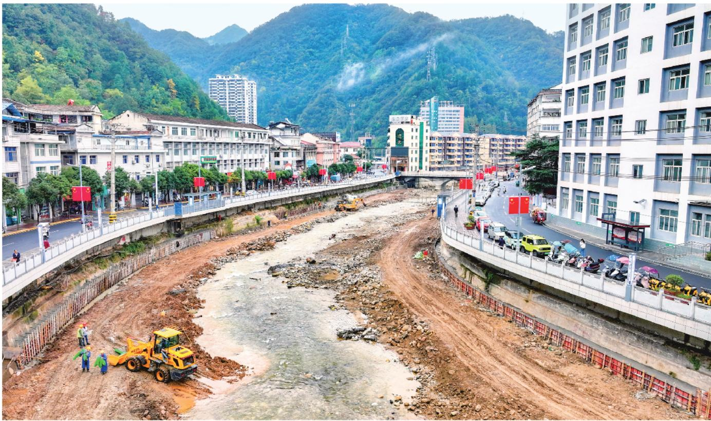
宁陕县水环境治理项目计划投资3500万元,主要对长安桥至仁安桥范围内污水主管道实施改造,计划新建管道3442米,配建漫步道2264米。同时,结合河道实际建设排水暗涵水景观道、悬挑观景平台、河道游人亲水设施,打造河道生态景观,预计2024年6月前建成投用。图为宁陕县水环境治理项目现场,工人正在进行污水管铺设施工。
