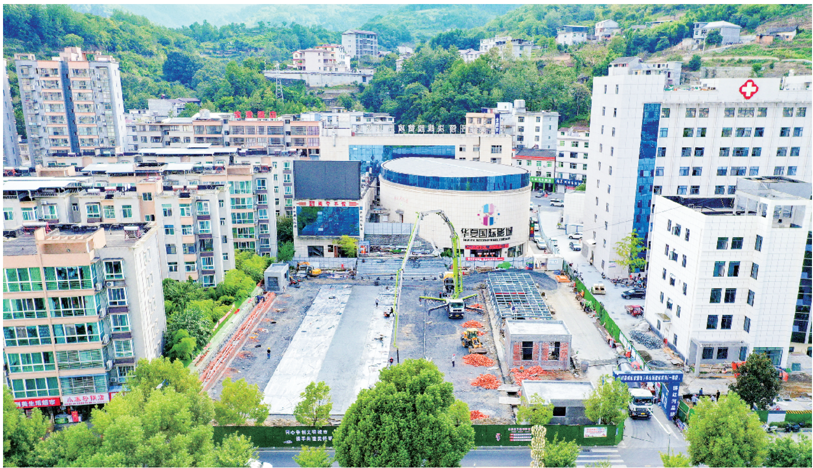
平利县发投集团公司以产业投资为重点,搭建平台、惠民民生、促振兴,自2021年以来,在城建设上先后新建10个地下智慧停车场和10个临时停车场,改造提升5个路外停车场,目前正在实施西大桥片区商业综合体项目的开发建设。图为在建的城南篮球场地下智慧车库建设工地。 王福摄
