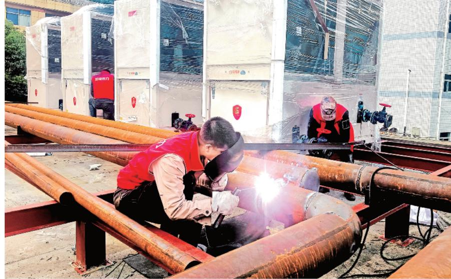
近年来,宁陕县积极推行分布式清洁能源集中供暖改造,今年计划总投资6000万元,新(改)建供热站3处、铺设供热主管网1500米,供热面积达12万平方米,涉及850户。图为工人们近日在三星电信局家属院,安装清洁能源集中供暖机房。 王辉 摄
