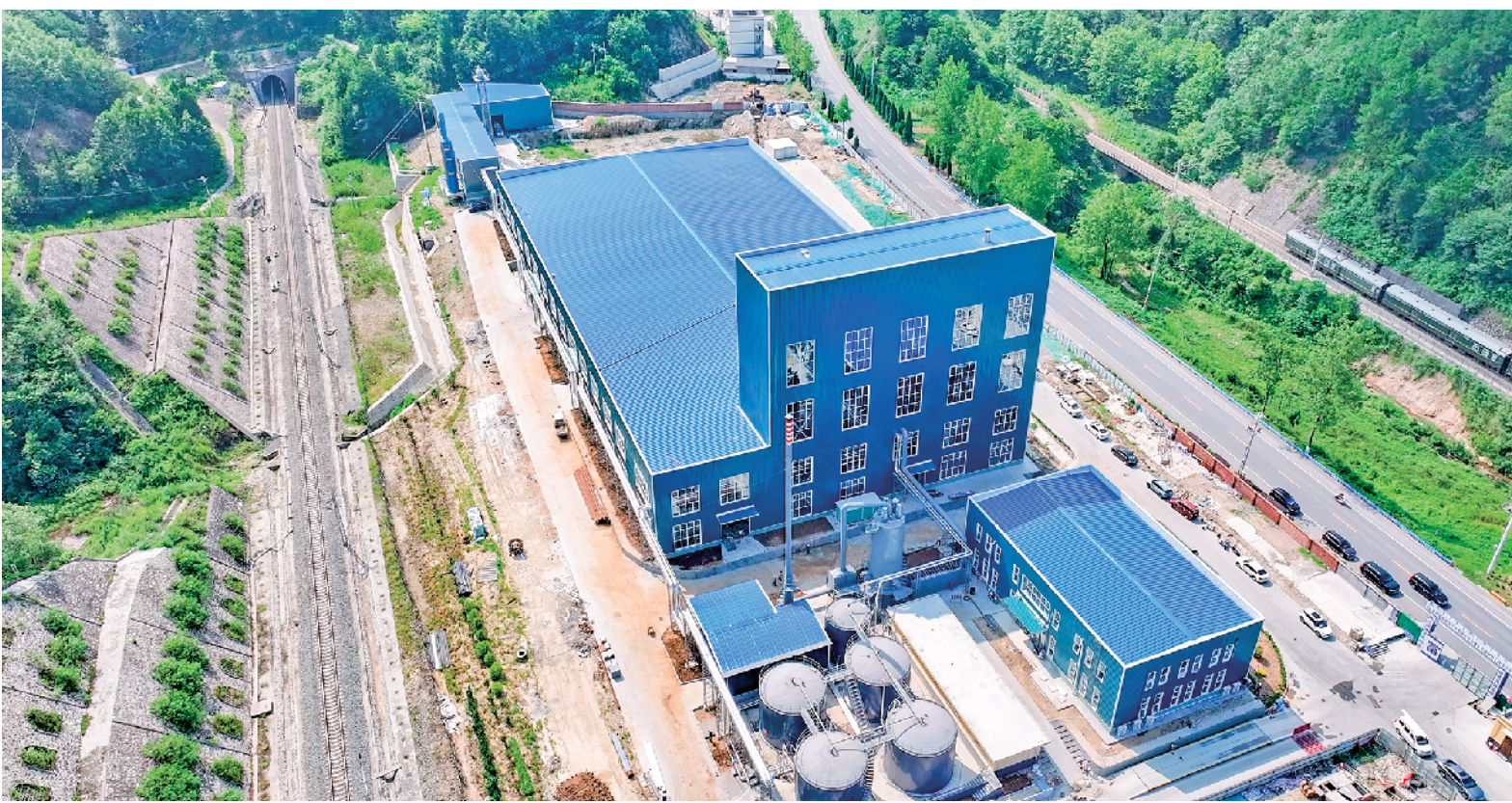
太伦新材料项目现场。汉阴融媒体中心 黄智发 摄
