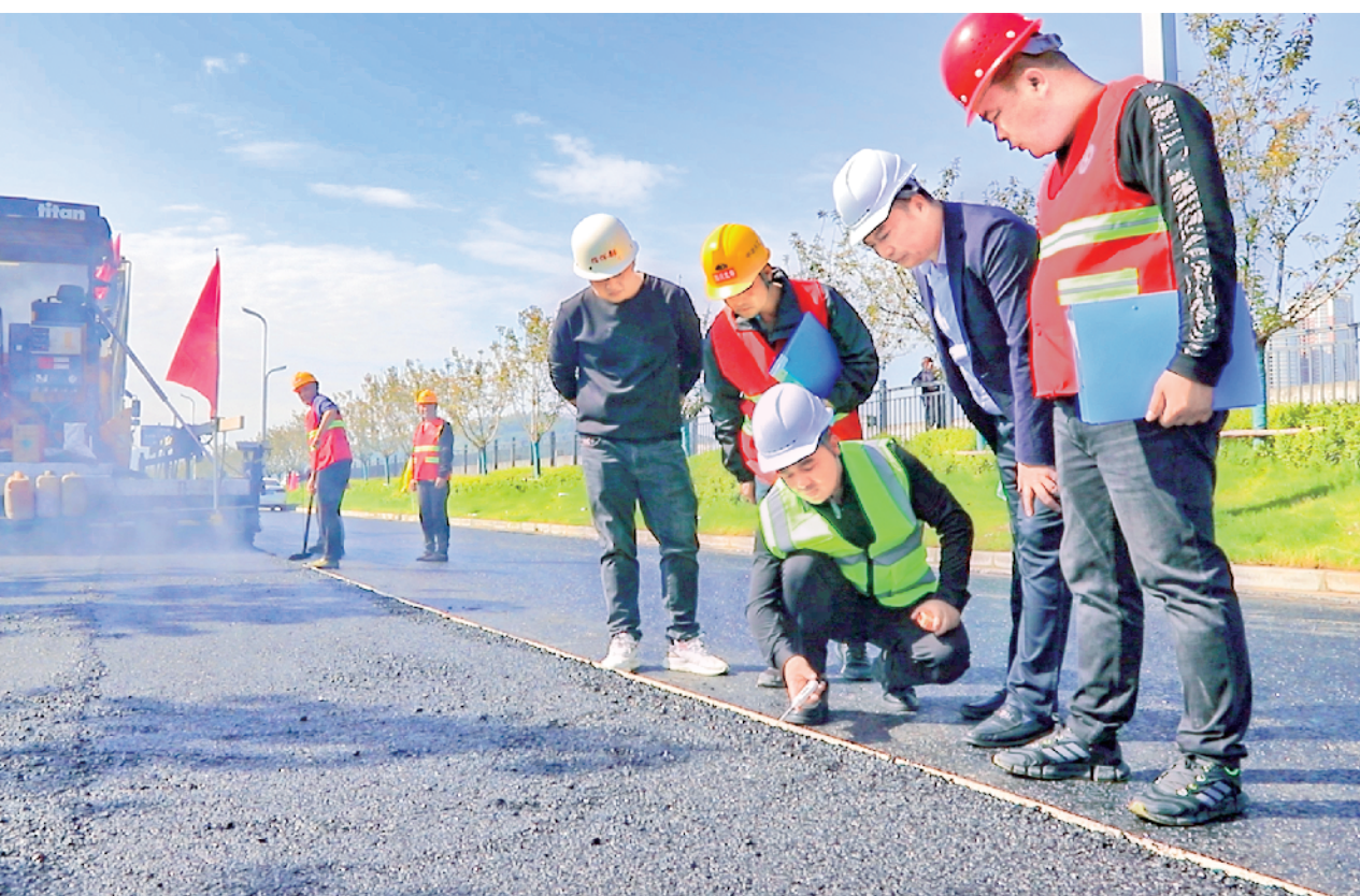
为确保金川街沥青上面层铺设质量达标，10月17日，专业技术人员利用电子测温仪检测沥青路面铺设温度。
