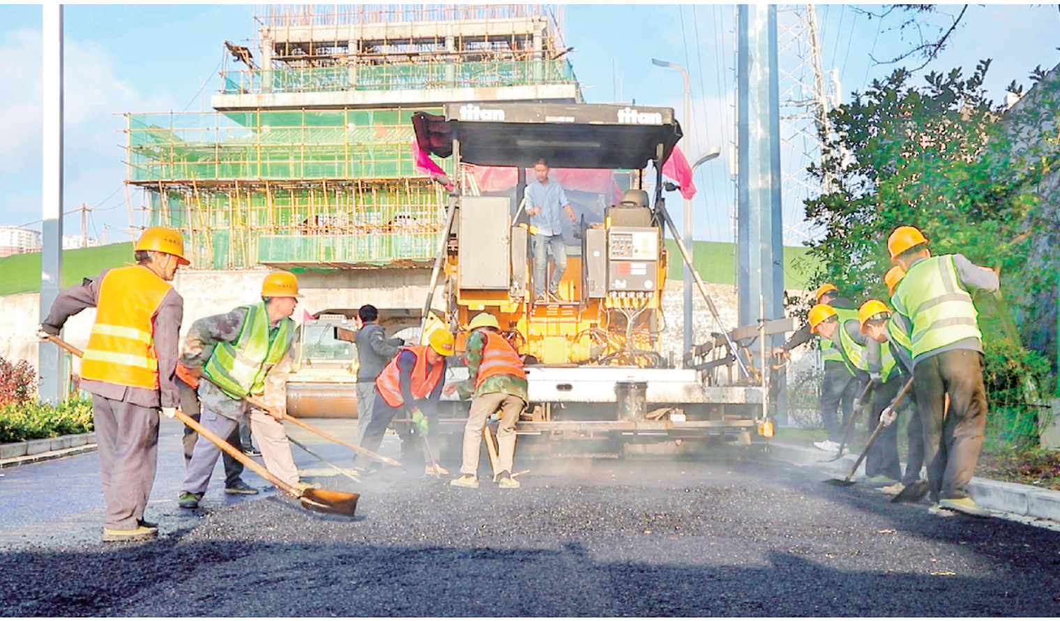
启动。金川街、白云路、金环路工程沥青上面层铺设工作全面启动。钱运立 杨再摄
