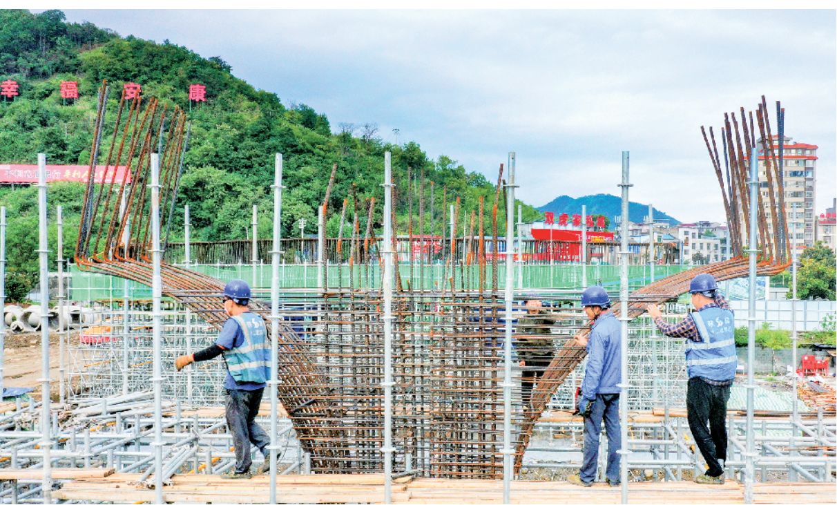
图为平利县西大桥改建项目施工人员进行桥墩变截面钢筋安装施工。
