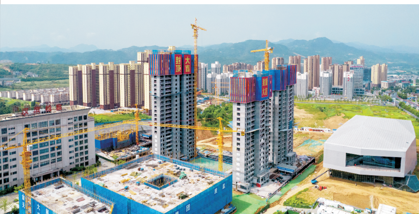
3、4、5#楼全面封顶 实景呈现
