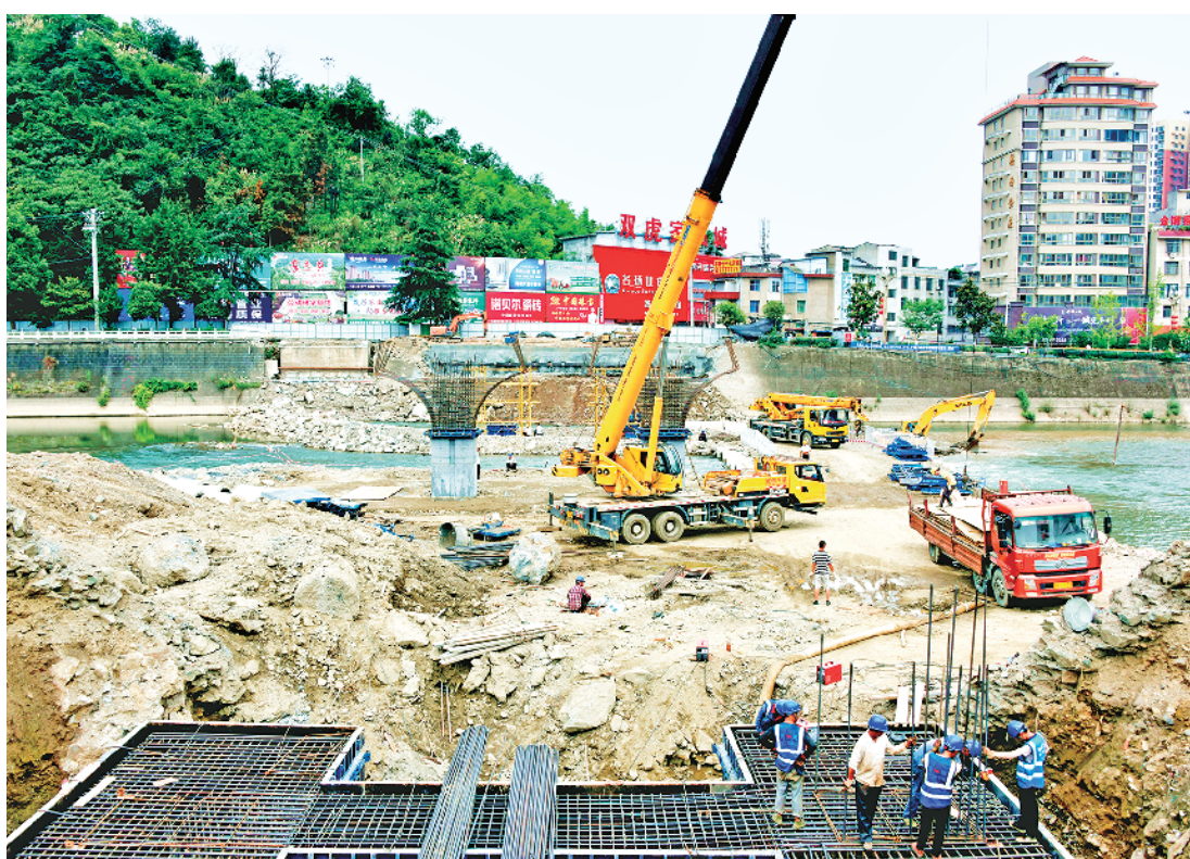
平利县西坝河大桥改建工程路线全长约1.5公里,采用双向四车道建设标准。建设内容主要包括桥梁工程、路基工程、路面工程、排水工程、照明工程、交通安全设施等。西坝河大桥改建工程对消除安全隐患、改善城区路网结构、提升桥梁通行能力、促进片区开发建设和体现“西坝河”的作用具有重要意义。
