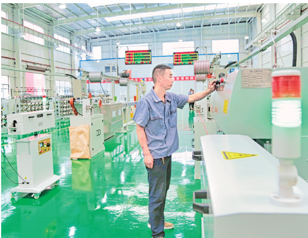
今年3月开工建设的汉阴县年产15万吨光伏线缆生产线项目,利用3000平方米标准化厂房,实现了快速投产。该生产线是光伏产业的补链强链项目,对促进光伏能源产业发展具有重要意义,还将为当地创造就业机会,具有较强的经济和社会效益。 吴单 摄
