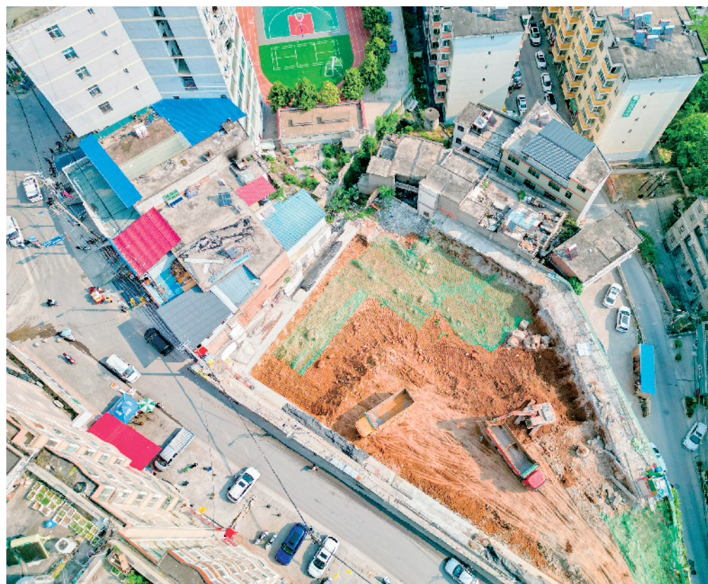
今年以来,旬阳市小河镇秉持“发展要、项目为王”的战略共识,实施市重点项目5个。坚持定期协调和现场观摩制度,强势推动项目建设加力提速。图为该镇商贸中心项目建设现场。 郭丽侠 摄
