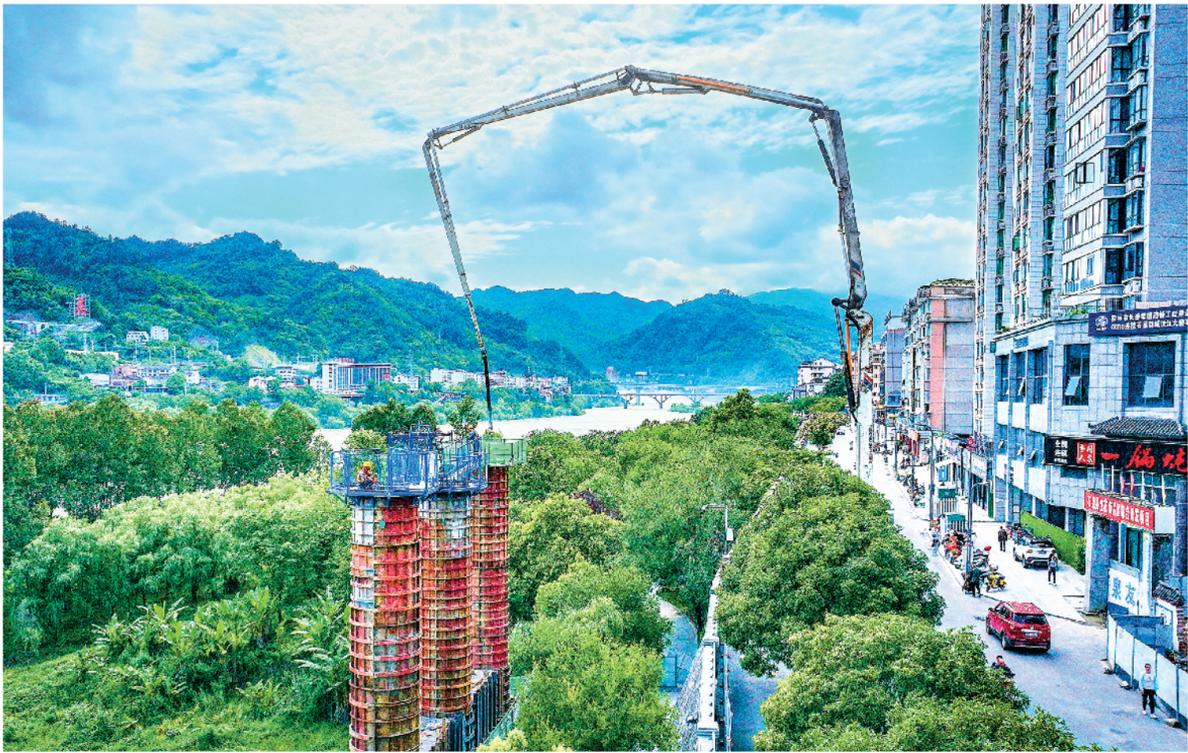
六月五日,(右)连接石泉县、城坎江大桥项目施工现场机器轰鸣,高昂的混凝土泵车臂架伸向高空,源源不断输送混凝土,加快一号桥墩浇筑工作。据悉,石泉县围绕“三个年”活动狠抓基础设施项目建设,预计六月底即可完成汉江大桥引桥墩建设。
