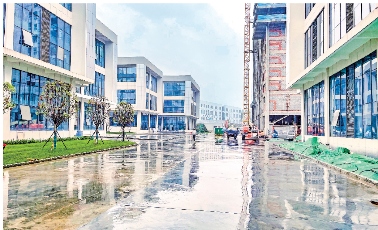
紫阳县农业产业科技创新中心项目进入扫尾阶段
