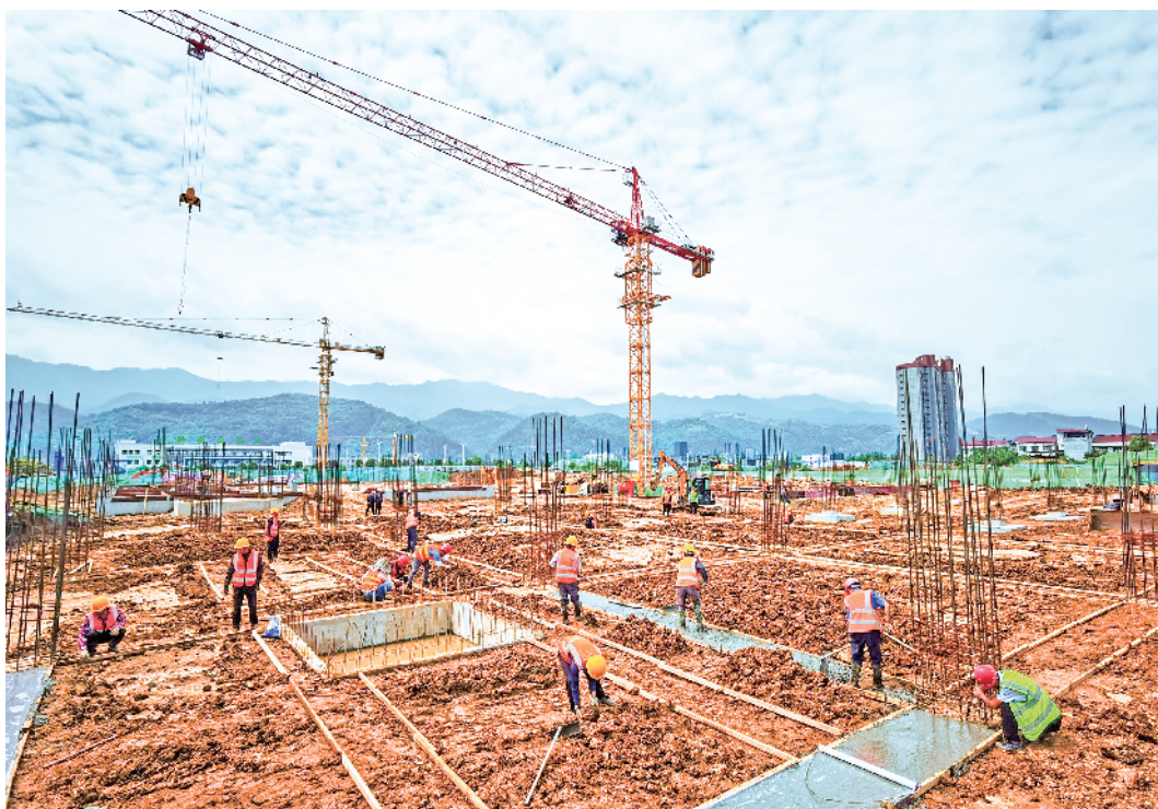
紫阳县碓窝生态工业园区计划用3至5年,分四期建设200万平方米标准厂房。今年10月在紫阳县飞地园区启动项目一期十万平方米标准厂房桩基工程和动力中心主体工程已全面完工,工程于5月22日一期项目施工现场。
