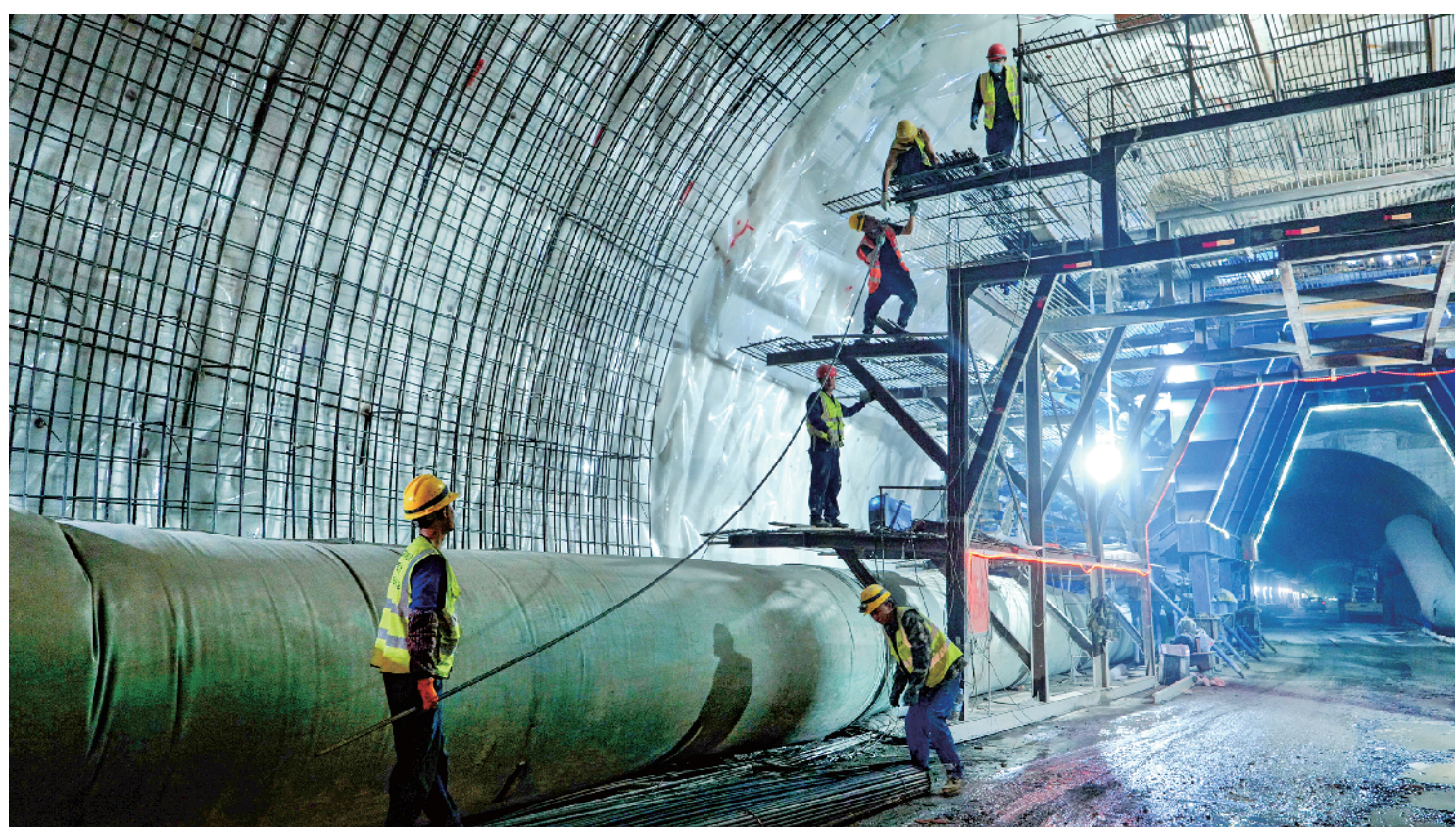
巫溪县至镇坪县高速公路控制性工程巫溪隧道左洞近日顺利贯通，为巫镇高速年底通车奠定坚实基础。 乔洛阳 摄
