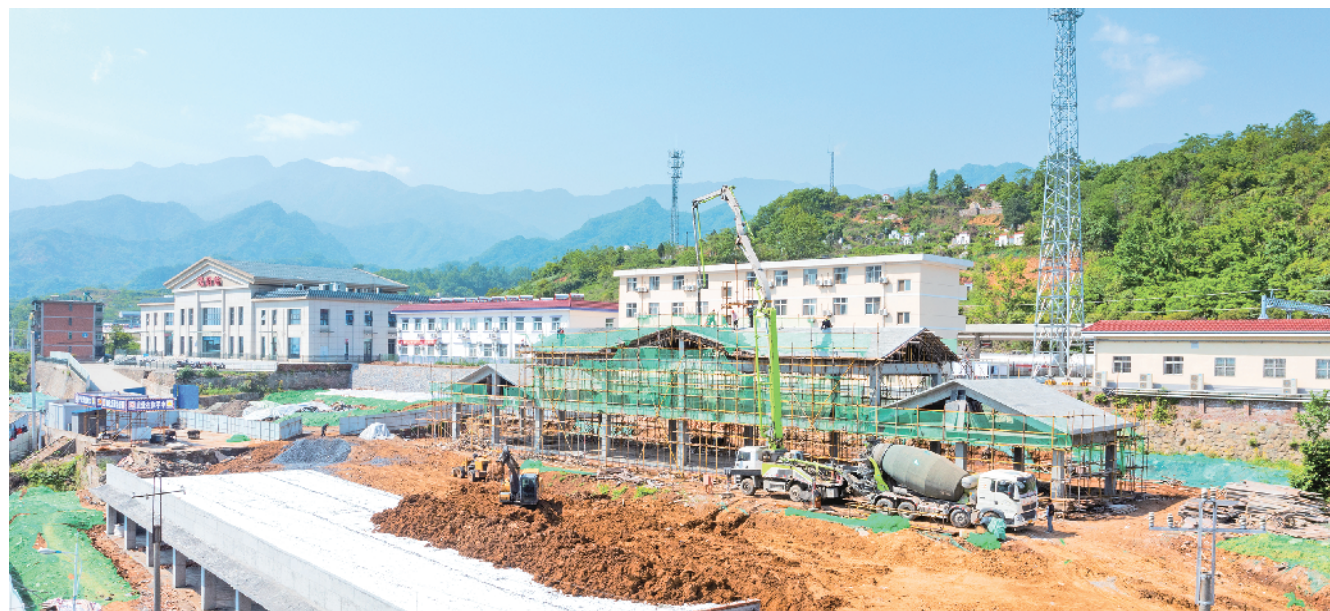
正在抢抓工期、赶进度。在汉阴县火车站前广场项目建设现场,建筑工人们
