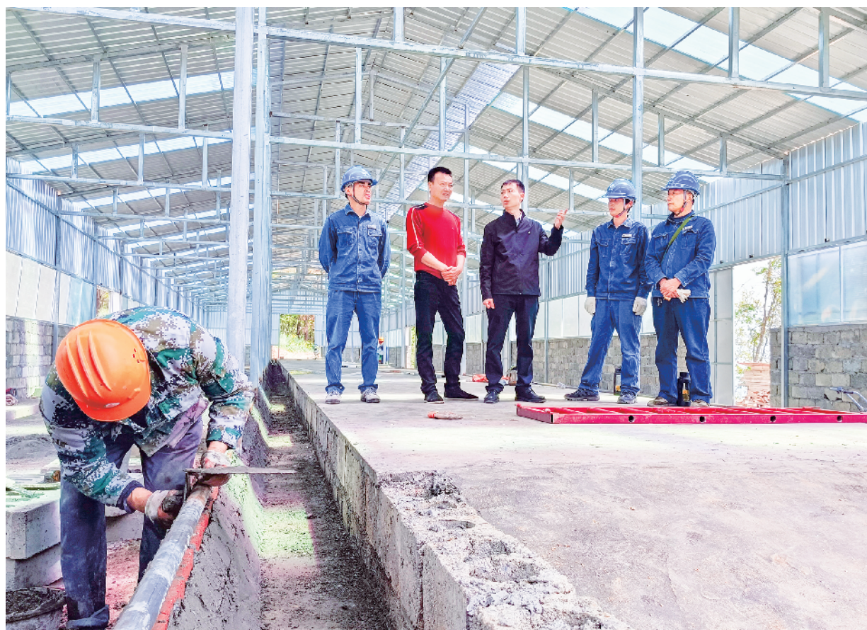
位于紫阳县红椿镇的立早农业有限公司自动化养殖场即将进入机械设备安装阶段,4月25日镇村包联干部和镇供电所职工一同解决厂区用电问题。
