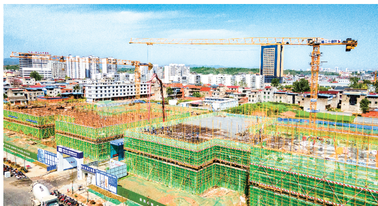
4月10日,在汉滨区五里镇工业园区纺织城二期重点项目建设现场,一台台大型设备正忙碌作业。为确保项目建设进度,五里镇党委政府坚持项目建设第一支撑、招商引资第一要事、营商环境第一保障、争先进位第一抓手,实现了项目建设“开门红”。
