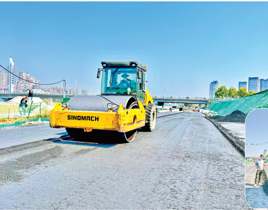
安康城区金川街是西坝片区市政道路工程的重要组成部分。目前已完成1600米面层铺设,工程人员正加紧下穿三桥段雨水顶管及西段300米道路的水稳铺设,南侧绿化行道树同步栽植到位,预计今年龙马节前建成通车。
