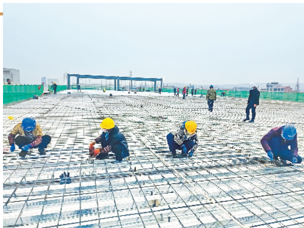
在宁陕县飞地园区标准化厂房二期第3批次项目建设工地,工人正在进行第三层封顶。
