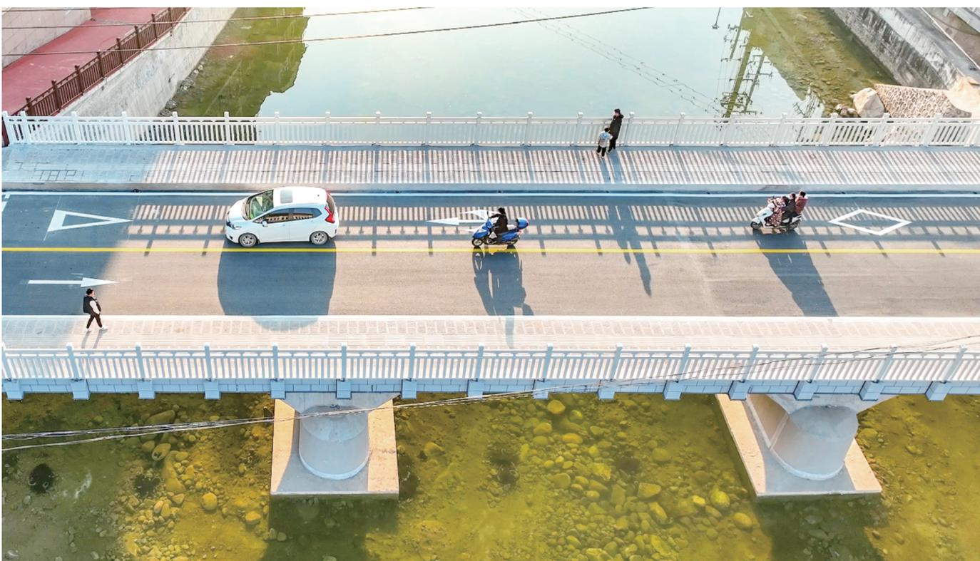
宁陕县实施县城迎宾桥提升改造工程，经过对桥基加固、路面铺设沥青、人行道拓宽、改筑护栏等更新行动，实现了旧貌换新颜，受到群众一致好评。图为改造后的宁陕县迎宾桥。
