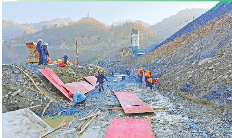
岚河重点段防洪工程建设。 田川 摄
