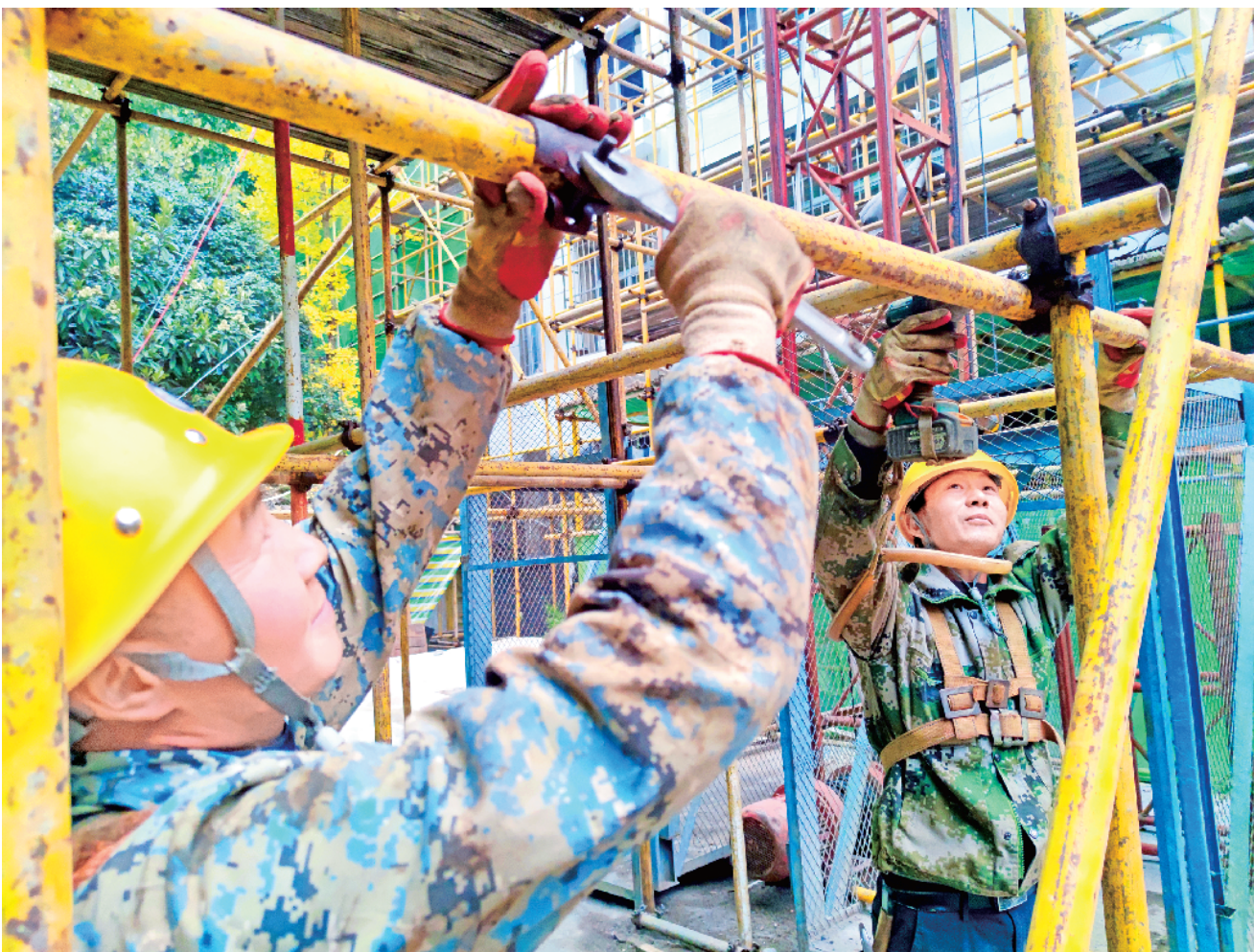
宁陕县农业银行小区改造现场，工程人员正紧张有序施工。据了解，今年宁陕县住建局计划完成11个老旧小区改造，目前已经完成8个，3个共同缔造试点小区正在稳步推进。王辉 摄
