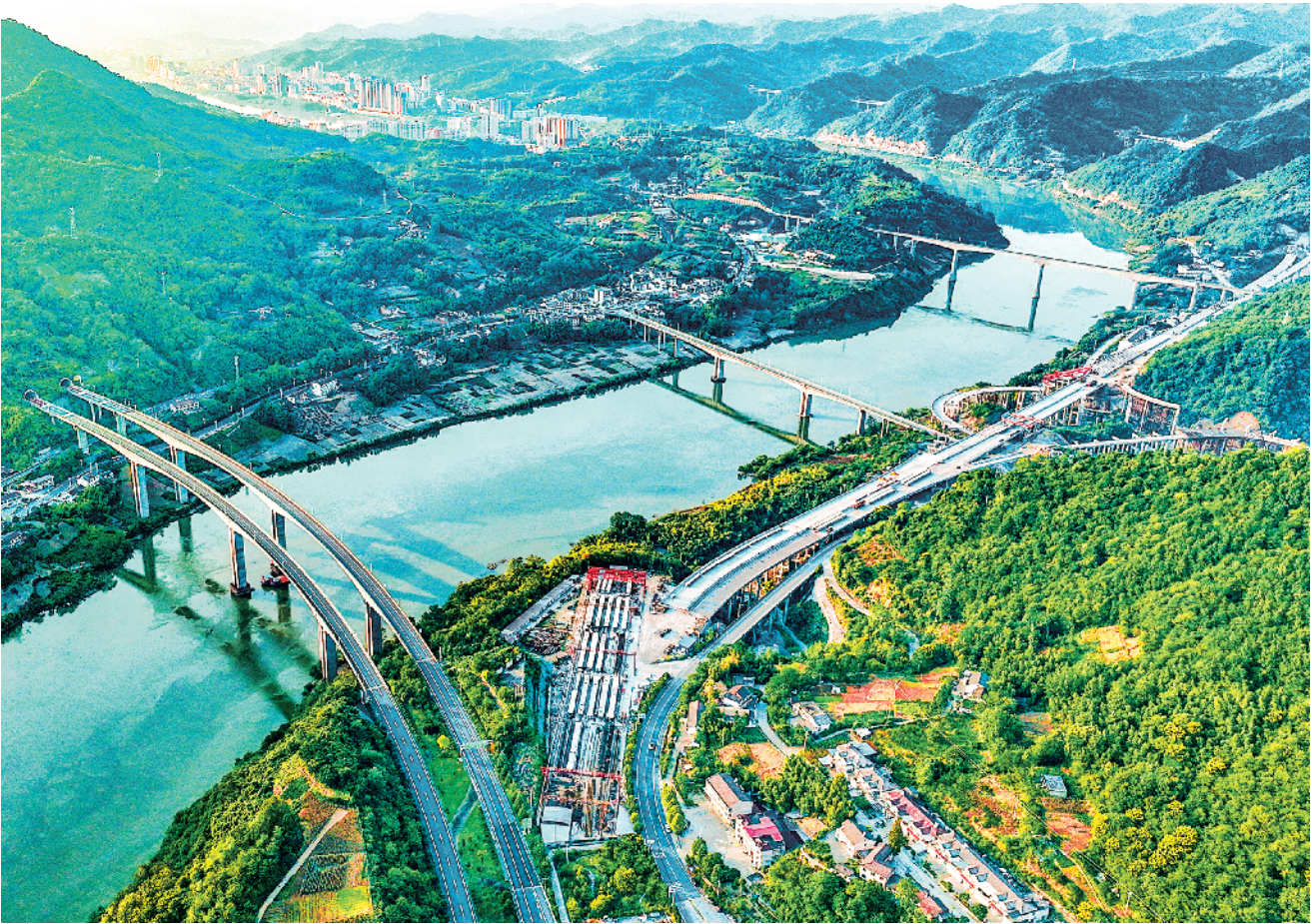
空中鸟瞰石泉县城东片区，十天高速、G316国道、阳安铁路跨江大桥一字排开，汉江北岸石宁高速即将贯通，纵横交错的交通路网，是近十年石泉交通飞速发展中的一个缩影。
